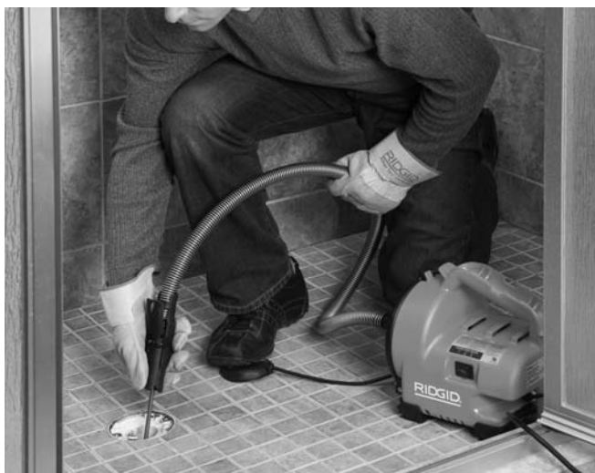
Figure 12 – Utilisation de l'appareil avec AUTOFEED
