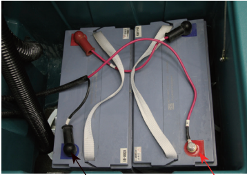
Cable de batería negativo (negro)
